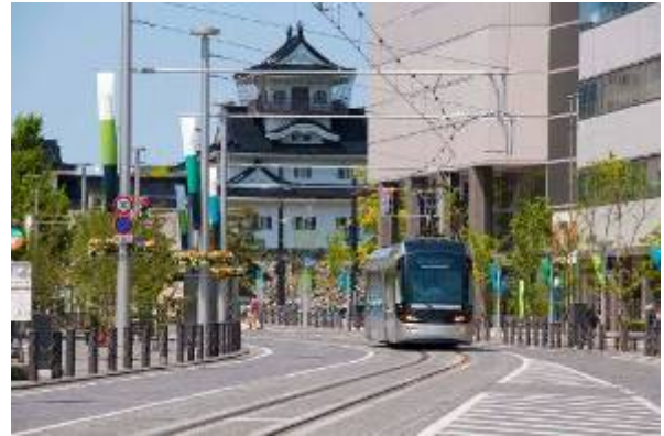
大手モールから富山城址方面を望む。トランジットモールの景観を目指し歩車道を自然石で一体舗装とした。
