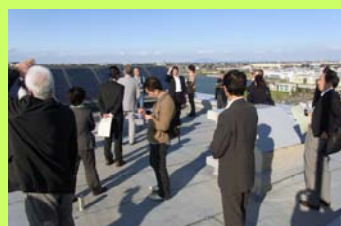
集合住宅屋上に設置された太陽熱利用システムについての説明風景
