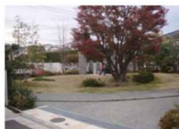
法人で所有・管理する地下式調整池・上部広場 〔プレイススクエアセンター北（神奈川県横浜市）〕
