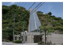
法人で所有・管理する斜行エレベーター 〔グリーンヒルズ湯の山（愛媛県松山市）〕
