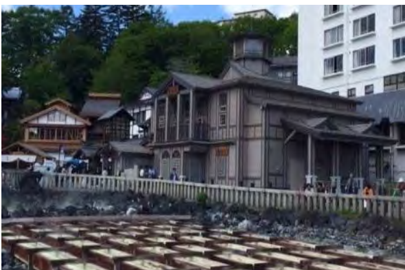
草津温泉の伝統文化「湯もみ」を伝承する施設「熱乃湯」。建築物の高さや屋根形状、壁の仕様、看板類の大きさなどを景観ガイドラインに盛り込み、街なみが後世へ引き継げる工夫がされている。
