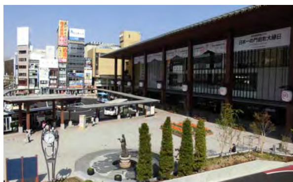
歩行者専用デッキから大庇・列柱を望む。「善光寺のような歴史性、伝統性、仏閣にあるゲート性」や、「自然風景のようなスケール感」、「樹木に囲まれた木陰の空間」をモチーフとした。
