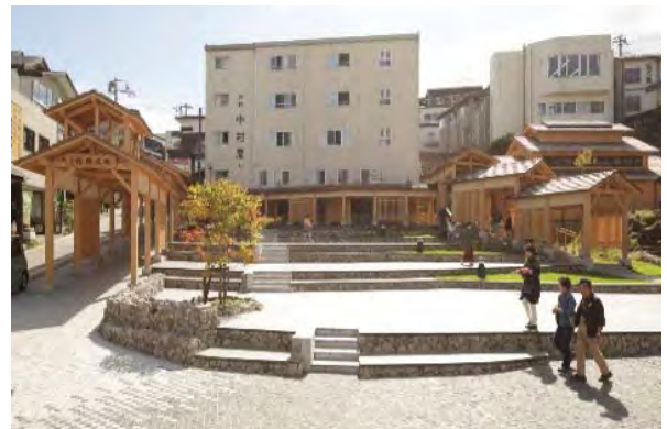
浴衣姿で温泉街の風情を肌で感じていただくための施設として、木回廊と石畳を敷いた棚田風の多目的広場「湯路広場」が新たに誕生。
