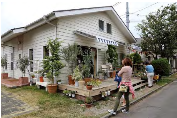
屋根の構造を 2×4 構造とし、屋根裏部屋に住むことができ、床暖房がある「平成ハウス」。米軍ハウスの小屋組みはトラス構造であったため、屋根裏に部屋をつくることができなかった。屋根裏部屋に住んで店を持つことができ、借家であるが、内装を自由にしてもよいとしている。
