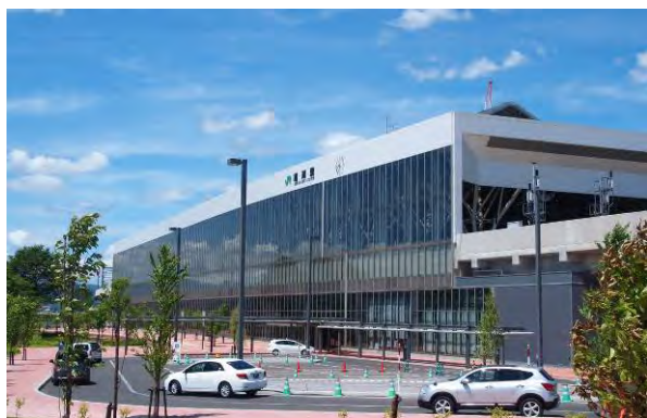
旭川駅：外観を南側の駅前広場より臨む。
