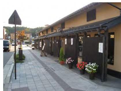
和風の外観(格子、庇、色彩、緑化など)を意識して新築された建物。
