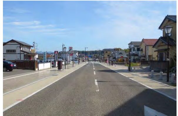
竹根通りを西から東に見る。電線地中化により、白猪山手前の森が背景として綺麗に見える。
