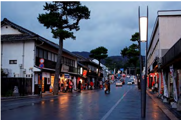
通りに植えられた松にちなみ松の葉をイメージさせる街路灯と、電線共同溝整備による架空線撤去によって開放感溢れる空間となった神門通りの夕暮れ。
