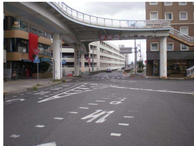
写真カ JR土浦駅東口広場から 土浦高架道方面
