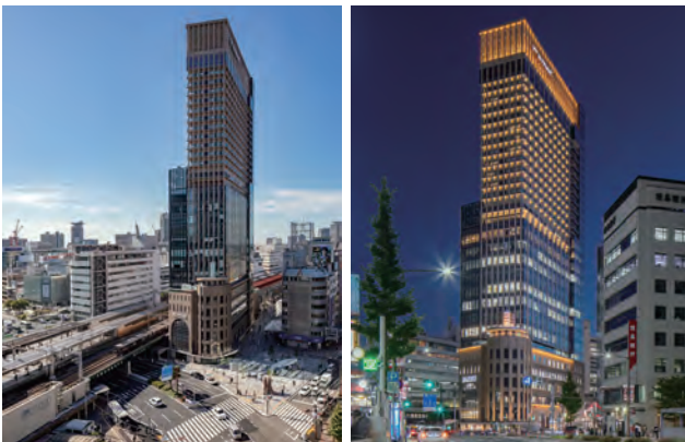
当地区は阪急神戸三宮駅と北側サンキタ広場及び南北の周辺街路を含む再整備事業。
