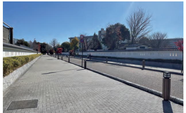
市立第二中学校前から杉山門方面に向かって見通す。学校施設の外構を白壁塀として整備を行った。
