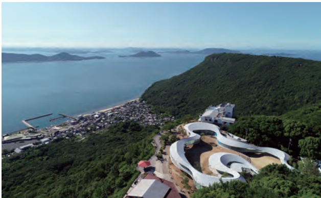
瀬戸内海国立公園内にある「屋島地区」は、「屋島スカイウェイ」で結ばれた山上区域（写真）と山麓区域から成り、眺望・景観に優れた自然環境と、長い歴史に彩られた人文景観が豊かな、高松市を代表する観光地である。
