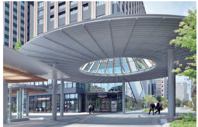
広場・歩行空間・各施設出入口が交差し広場の中心となる円形の大屋根下空間。長さ5.2mの扇形アルミキャストパネルを48枚連ねた。
