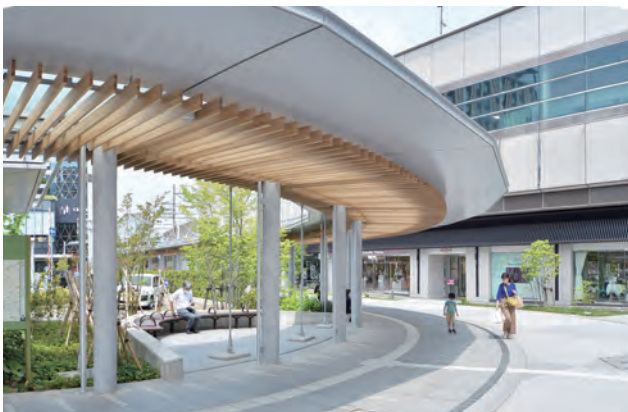
流線形の広場に呼応する歩行空間。駅高架下商業施設（右奥）は無窓壁面をガラス壁にし、金沢らしい意匠を凝らした庇に全面改装した。
