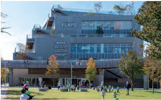
芝生広場から「FLAPS」をみる。北側の広場にも日差しを届けるセットバックした「山」型の建築形状により、明るいひだまりの広場が実現された。
