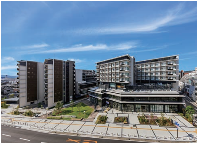
対象地区の東面全景。 周辺建物などに配慮した建物の分棟・雁行配置。
