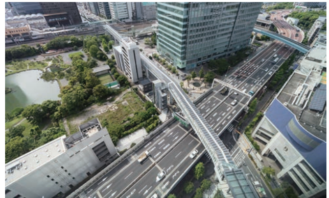
港歩行者専用道路8号線：賑わいを分断していた鉄道高架と首都高速道路高架上に歩行者動線を形成。
