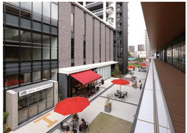
駅前中央通りから来街者の誘導を図り、滞留空間を演出した中央の公共空地。
