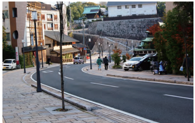
県道六軒家石手線を北から道後温泉本館を望む。県道六軒家石手線は道路・歩道整備・電線類地中化整備がされた。
