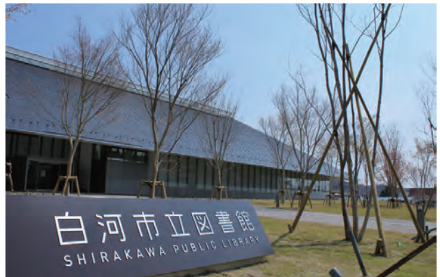
小峰城跡三重櫓への眺望景観に配慮した建物の高さや勾配屋根のデザイン、色彩が特徴的な白河駅前多目的複合施設。本市の新たなランドマークとなっている。
