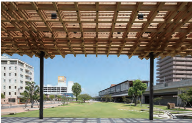
野外ステージから駅前交流広場を望む。野外ステージの梁には地元杉材を利用した小断面集成材を利用している。
