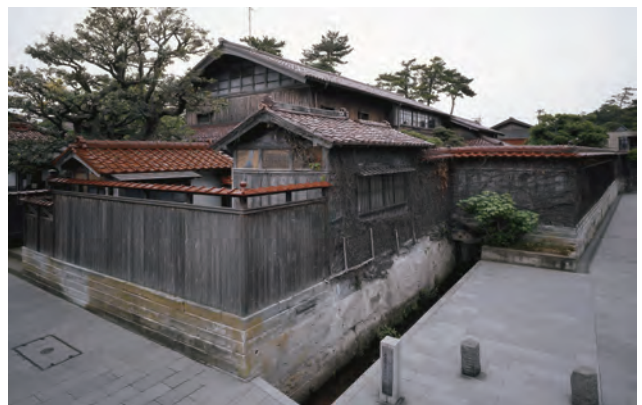
保存物件である船主屋敷。敷地は加賀橋立のまちなみ景観上大きな特色を持つ板塀で囲まれている。
