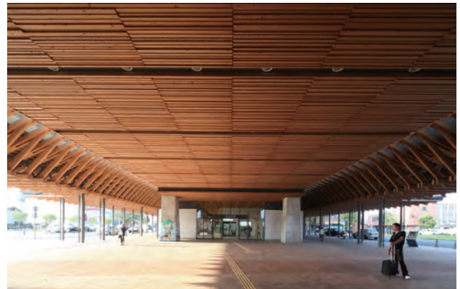
駅 1 階部分、コンコース天井の杉仕上げ材。断面の大きさの異なる部材を使用し天井に変化を与えている。高架橋の間隔を 21m、4 スパン連続とすることで、開放的な高架下空間を生み出している。
