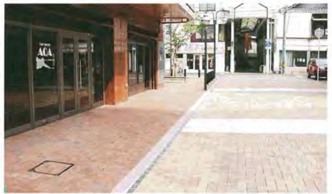
▲街づくり協定により建物1階部分はセットバックされている。また、民間のセットバック部分の舗装については道路の舗装と整合をとることとした。
