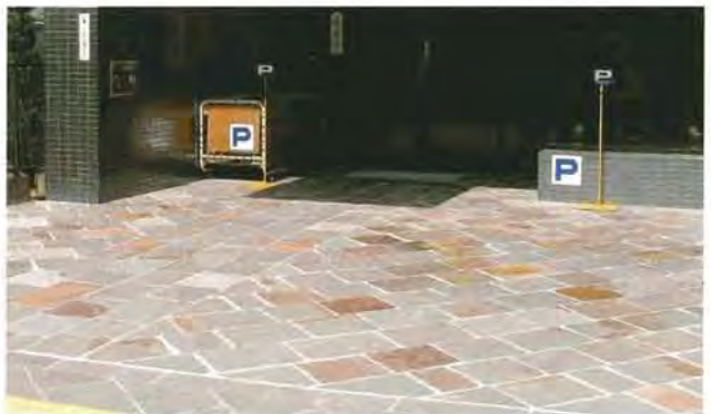
▲民地側の駐車場を歩道と一体的にしている。
