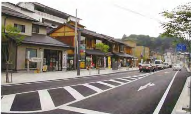
▲屋根を街路に面して平入りに揃えることにより、家並みの連担性を強調し商店街の統一を図っている。
