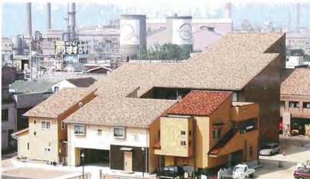
▲街づくり協定により屋根材を同一の瓦製品とし、3.5寸勾配北下がりの片流れ屋根で統一されている。
