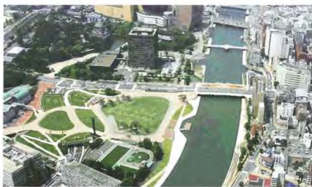
▲市庁舎周辺には、複合商業施設や紫川と一体となった勝山公園大芝生広場が整備された。
