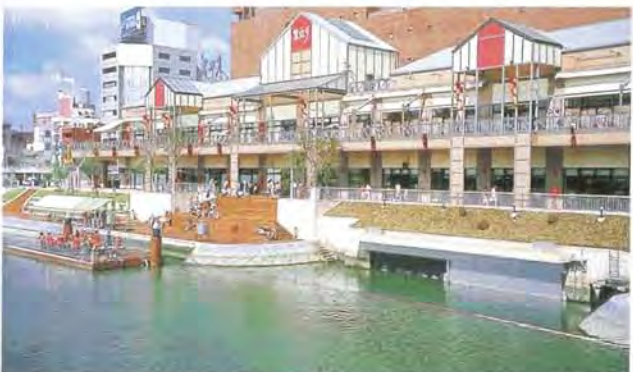
▲紫川右岸には河川と一体となって整備された民間の商業施設「紫江'S」がある。地下には、紫川の体験学習施設「水環境館」がある。ここでは、紫川を直接覗ける観察窓も整備された。
