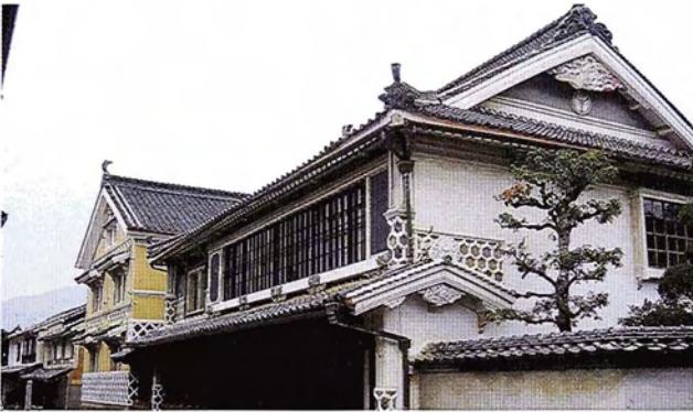
▲製蠶業で栄えた当時の豪商の屋敷「本芳我家住宅」。重要文化財に指定されている。平成18年9月、3か年に渡った修理事業が完了し、往時の姿に甦った。
