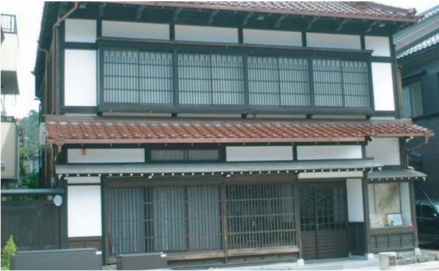
▲ 曳き家により町屋を再生し、通りの拠点施設として活用している。
