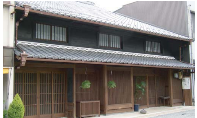
▲ 景観形成マニュアルに基づいた、家屋の修景例。格子の建具、真壁などで修景がされている。
