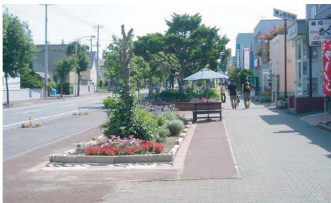
▲ 都市計画道路(南島松1号通)の計画幅員16mより更に広く、歩道と花壇用地8mを確保した箇所。沿線の恵み野商店会や「花の千人植え」で管理している。
