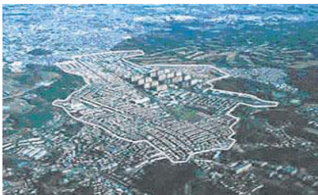
▲ 上空から見た緑園都市住宅地緑に囲まれ整然とした街並みが眺望できる。
