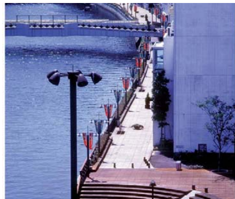
▲ しんまちボードウォーク通路。床、縁石、手摺り、ベンチ、照明等、主要部分がイペ材で作られている。
