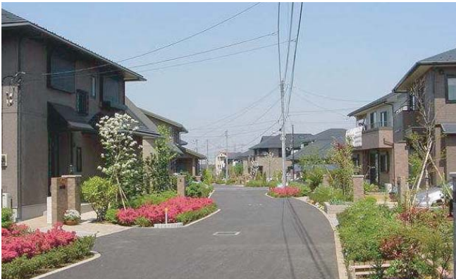
▲道路内植栽と協調緑化帯が一体となって緑豊かな美しいまちなみ。車の出入口を一か所に絞り通過交通をなくし、緩やかな曲線道路で車の速度を抑え、安心して歩ける。
