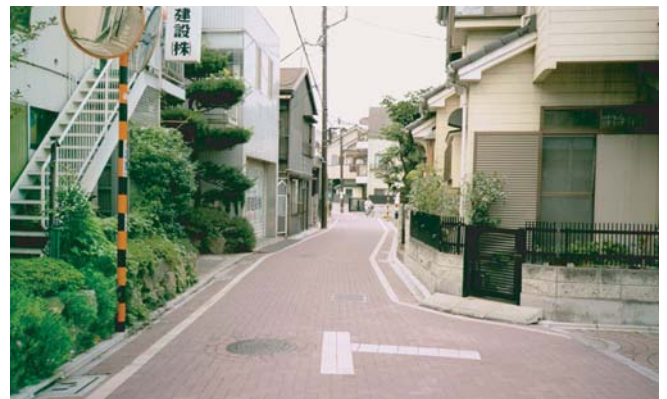
▲ 道路拡幅整備。
