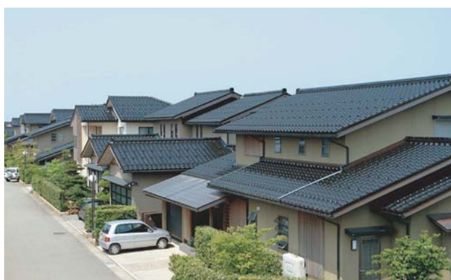
▲ 「金沢らしさ」を醸し出す落ち着いた黒瓦・勾配屋根の家並み。
