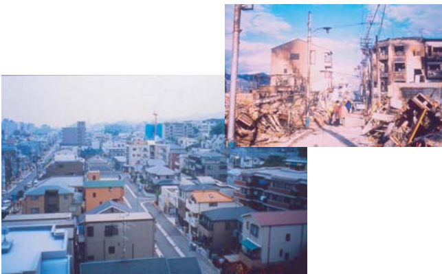
▲ 阪神淡路大震災による被災（右上写真）から立ち直った現在の松本地区の全景（左下写真）。
