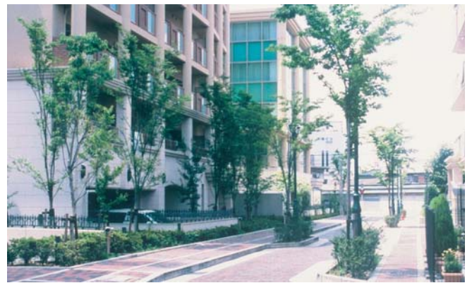
▲景観ルールブックに則り建替えられた建築物。
