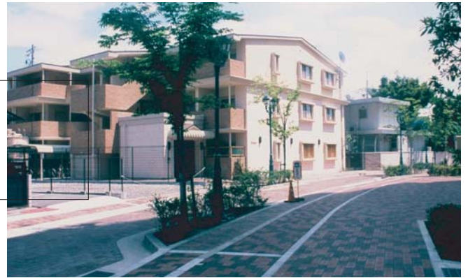
▲ガイドラインでコントロールされた建物。
