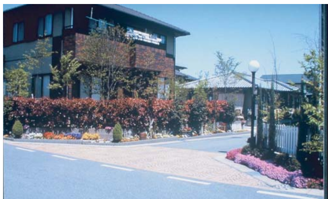
▲ 生活空間の入口にはイメージハンプを設け、コミュニティの領域性を明確にした。
