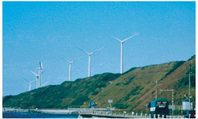
▲日本海オロロンラインの景観に配慮した集合型大規模風力発電施設。
