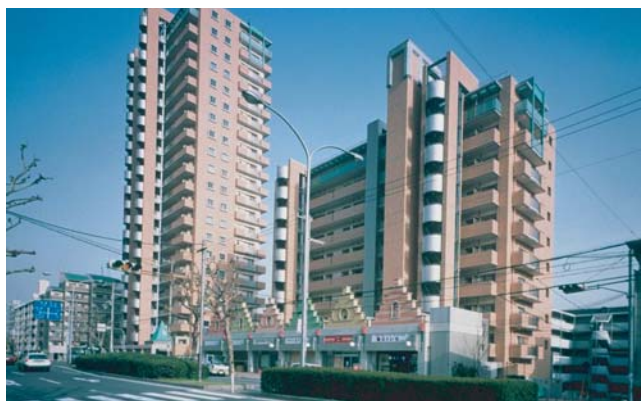
▲ 道路拡幅整備。
