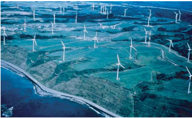
▲国内最大の集合型大規模風力発電所「上平グリーンヒルウィンドファーム」。
